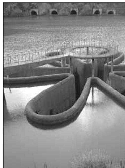
«Որոտանի հեկերի համալիր» ՓԲԸ-ի հիդրոէլեկտրակայան եզակի կառույցներից մեկը՝ Շամբի ջրամբարի հորանային ջրանցքը (մարզադրամադրակ)
